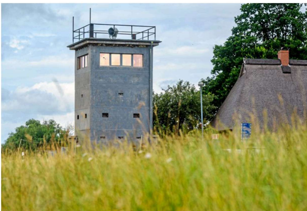
Seit Kurzem stehen auch die sanierten Grenztürme an der Elbe bei Neu Bleckede, Popelau und Darchau der Öffentlichkeit zur Verfügung. Foto: a/t&w
