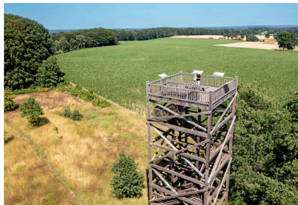
Der 16 Meter hohe Aussichtsturm im Naherholungsgebiet Hambörn bei Südergellersen ist frei zugänglich. Foto: a/t&w
